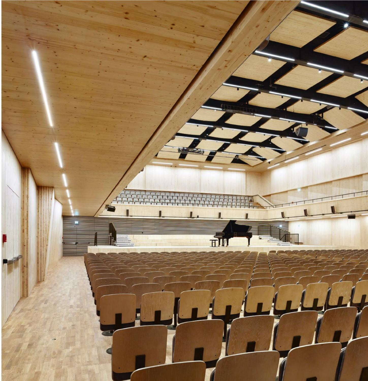
Die Wände des Konzertsaals sind im Zickzack gebaut: So ist keine Wand parallel zur anderen und es entstehen keine Flatterechos. Die Holzpanels an der Decke können zur Optimierung der Akustik verstellt werden.
